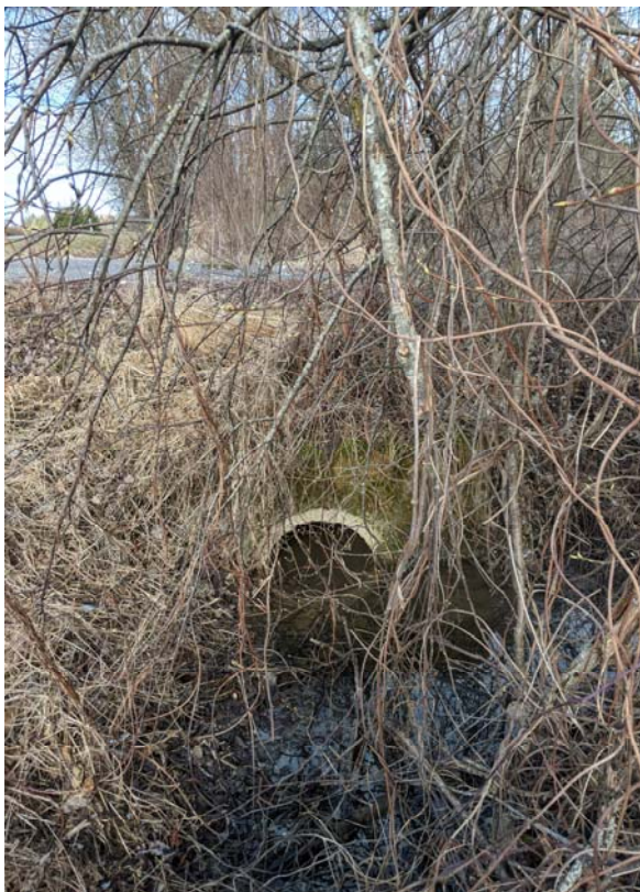
Olemasolev 50cm betoonitoru truup kapitaalse otsakuga, riigiteelt mahasõidul, väljavool, sissevool.
