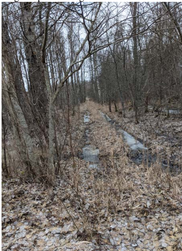
Jäätme tee pk 4+36, äravoolukraavi 100 mulle, voolab Tabra oja suunas, ca 2m laiune mulle.
